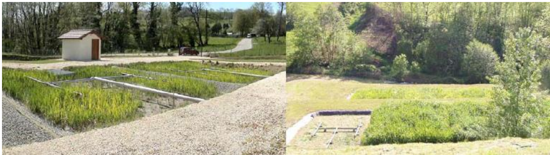
Photo 04 : Photos de réalisation de filtres plantés de roseaux [29].
