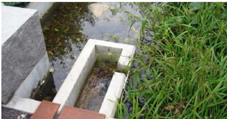
Photo 03 : Photo de réalisation du lagunage à macrophytes [29] .
