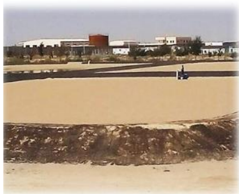
Photo 10 : Lit de séchage des boues [52].
