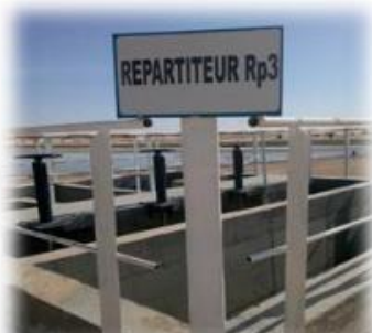
Photo 07 : Répartiteur vers les bassins d'aération [52].
