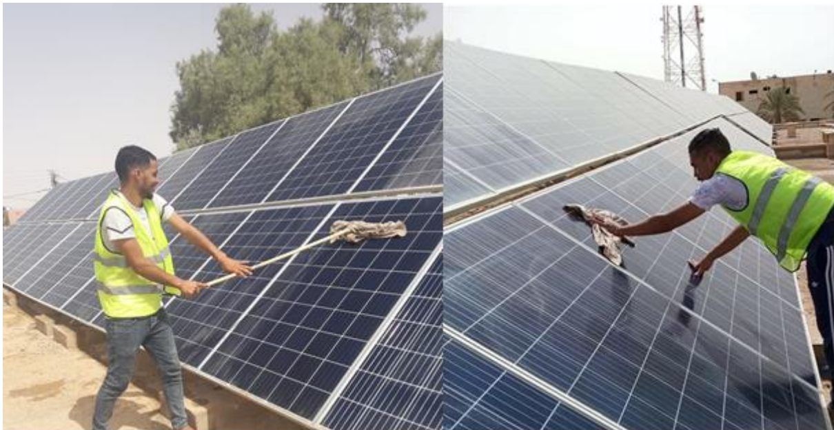
Figure III-12: Nettoyage des panneaux
