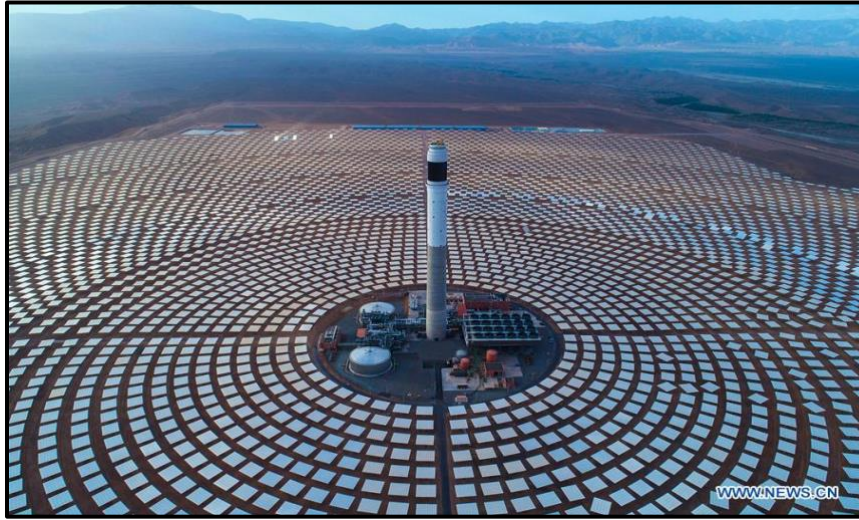
الشكل (9.1): برج الطاقة الشمسية [13].
