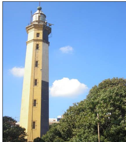
Figure I.2. Phare de Port Saïd réalisé en béton aggloméré Coignet (Egypte).
