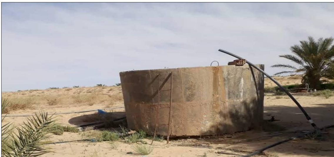
Figure 22: photo montre le réservoir d'eau.
