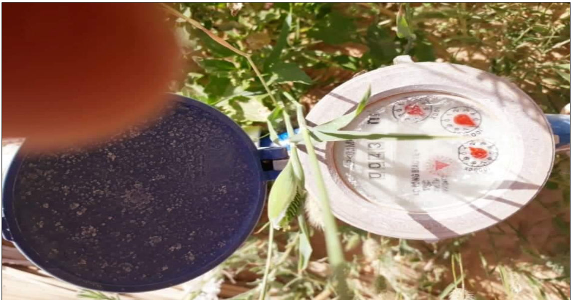
Figure 19: photo montre le Compteur d'eau
