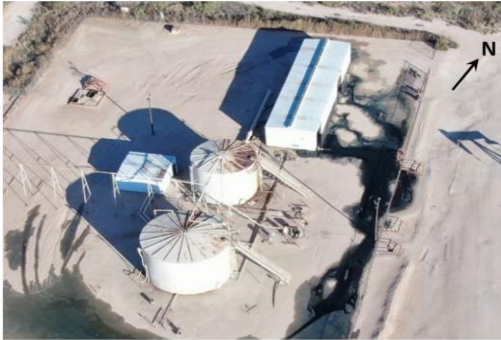
Figure III.2 Station d'injection d'eau Aghorn Foster D à Odessa, Texas
