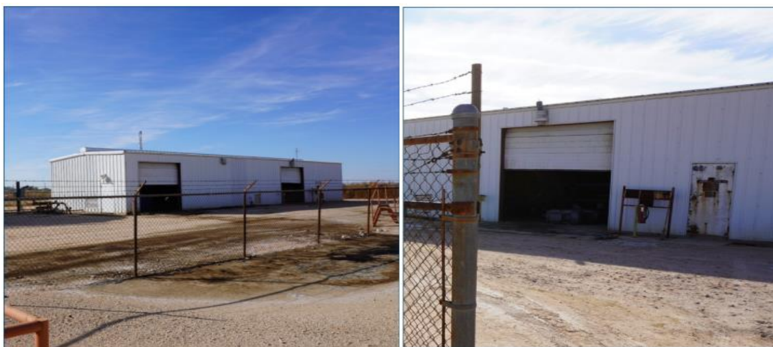
Figure III.9 Photos montrant les positions des portes de la baie.
