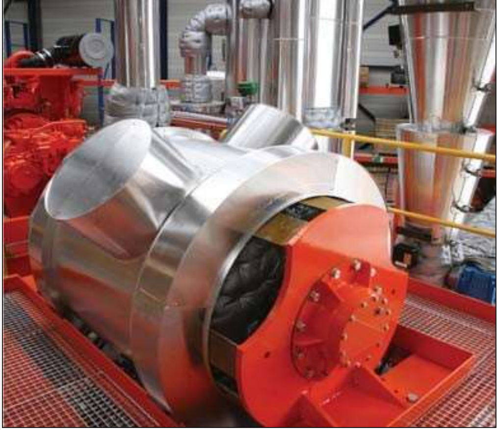
الشكل II.6: نظام الامتصاص الحراري TCC للتطبيقات البحرية أو البرية (Thermtech، 2008)
