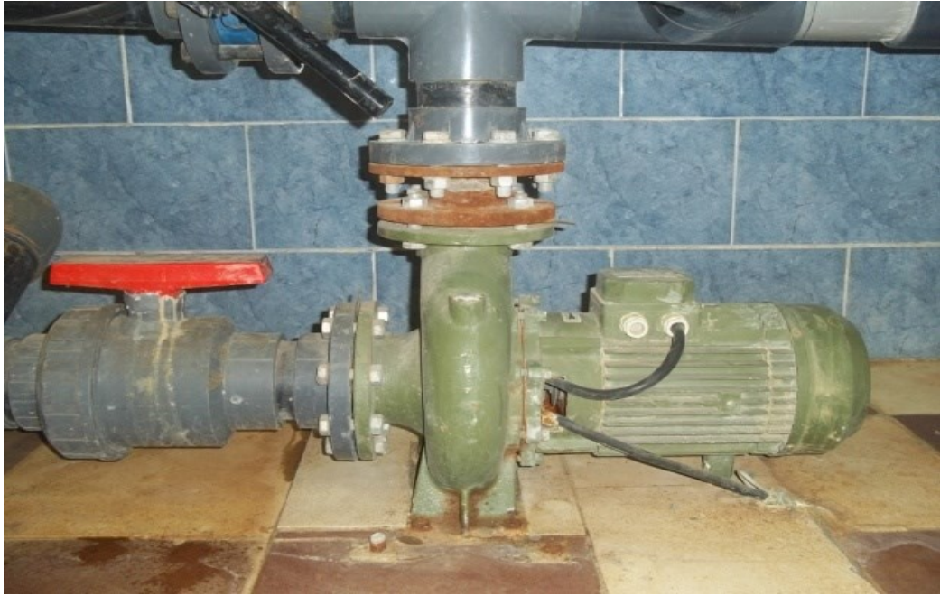
Photo IV.2 : Pompe centrifuge axiale
