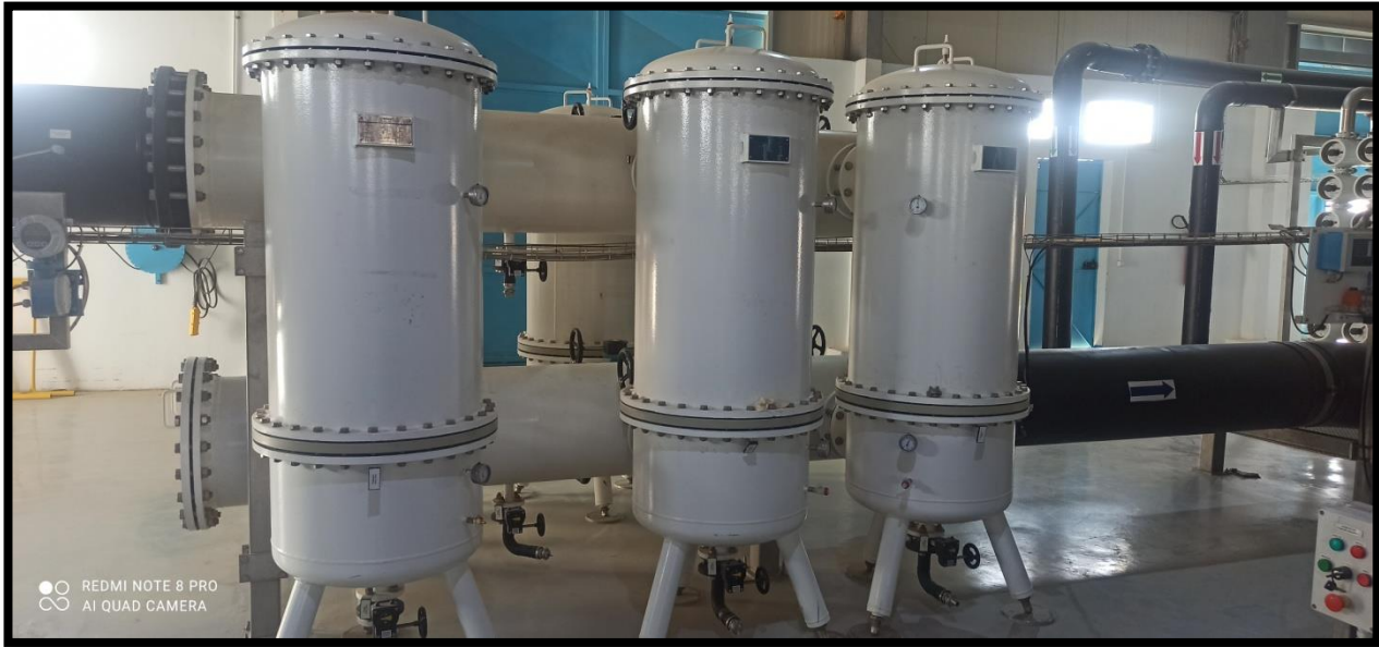
الشكل III-9: صورة توضح مرشحات الخرطوش .
