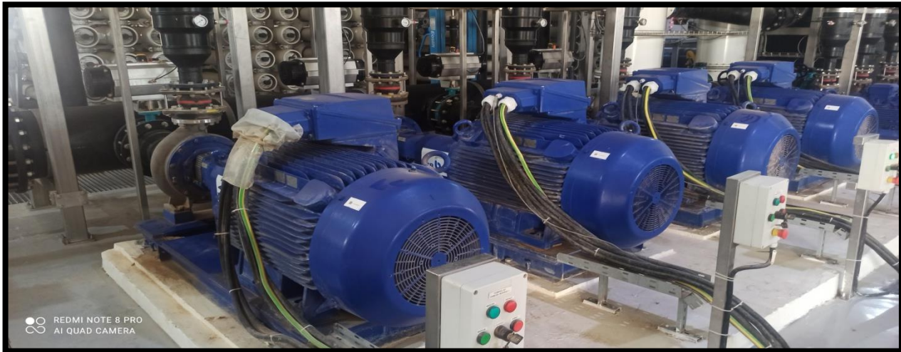
الشكل III:10- صورة توضح مضخات التغذية لأجهزة التناضح العكسي .
