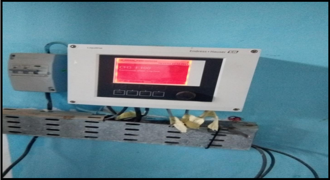
الشكل III -7: صورة توضح مسبار القراءة.
