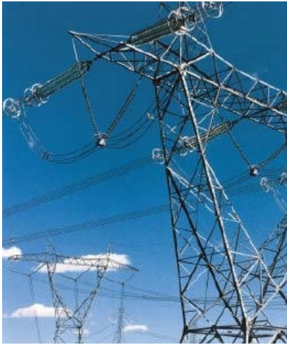
Figure II - 14. : Utilisation des anneaux de gardes.
