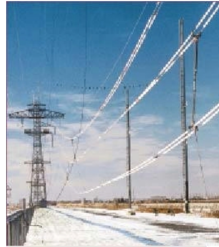
Figure II - 15. : Essais des nouveaux espaceurs sur la ligne expérimentale d'essais mécaniques de l'IREQ et installation en réseau en novembre 2000.
