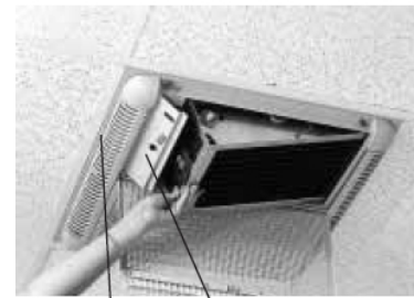
Figure III - 10. : Plaque de retenue de filtre
