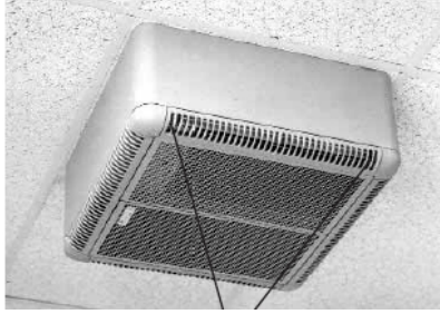
Figure III - 6. : Fermeture d'accès à la cellule
