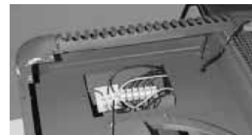
Figure III - 11. : Bloc de terminaux
