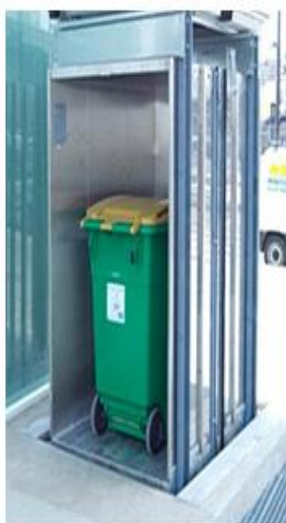
Figure I.2: Ascenseur de charge.
