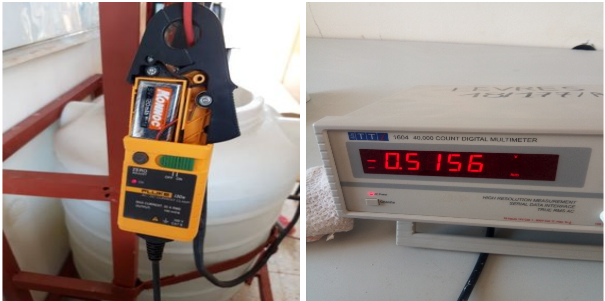
Figure III.27 – Opération de mesure de courant.
