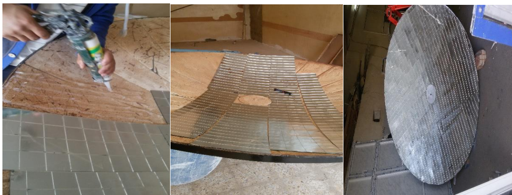
Figure III.5 : les étapes de collage le miroir.
