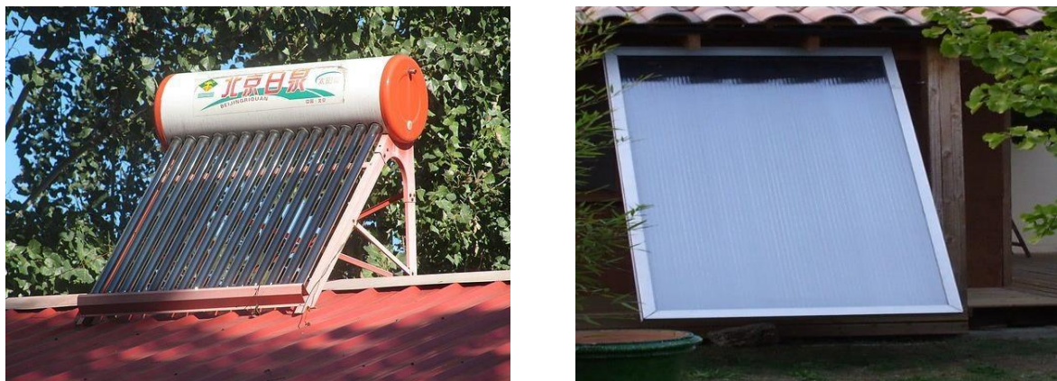
Figure I.2 : Chauffe-eau solaire à tubes sous vide en Chine et Un capteur monté en façade plan auto- construit.
