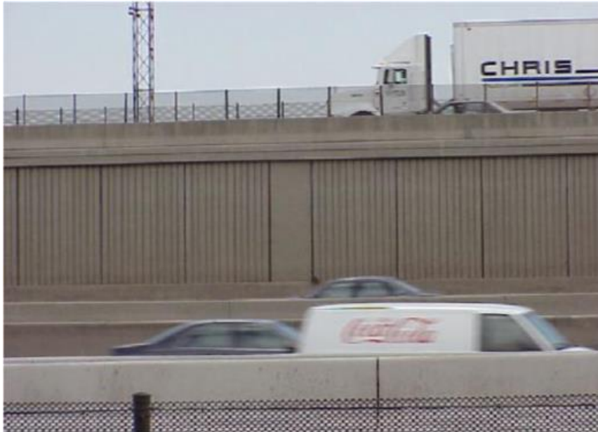
Figure 2-7. Panneau de pleine hauteur (d'après Abu-Hejleh et al., 2001)
