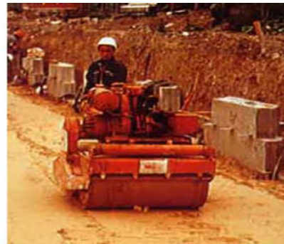
Figure 2-37. Photos du remblaiement et du compactage d'une couche de sol [7]
