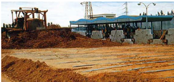
Figure 2-37. Photos du remblaiement et du compactage d'une couche de sol [7]
