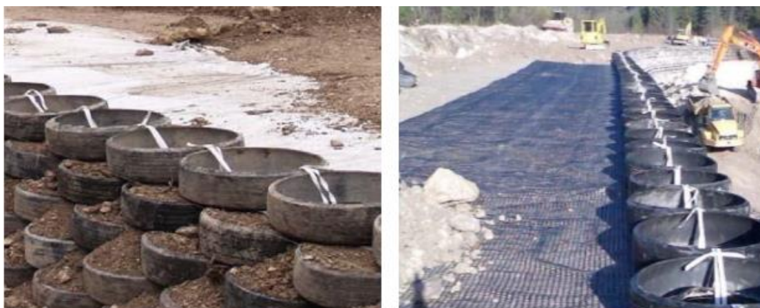
Figure 2-16. Parement en Pneu-sol
