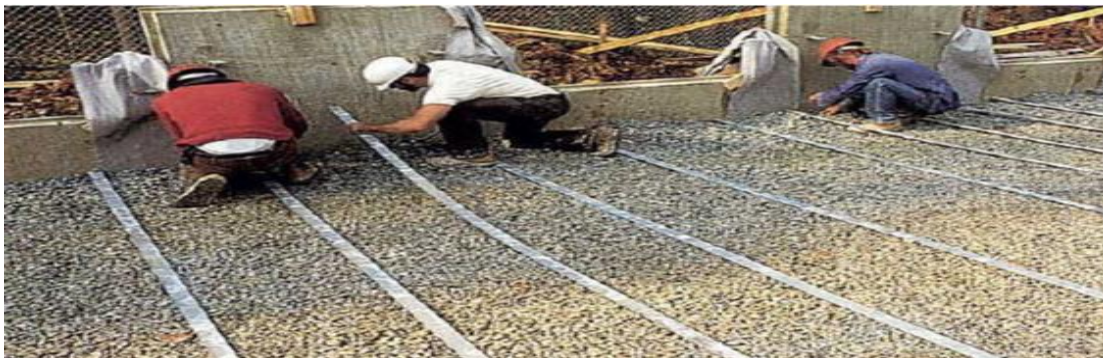
Figure 2-38. Photo de la pose d'un lit d'armatures[7]
