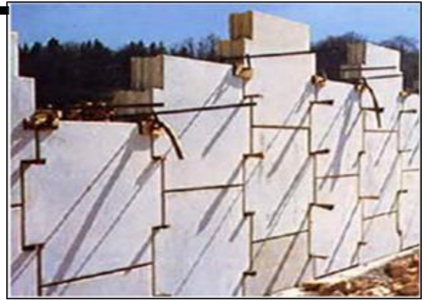
Figure 2-36: Photo du montage d'un niveau d'éléments de parement
