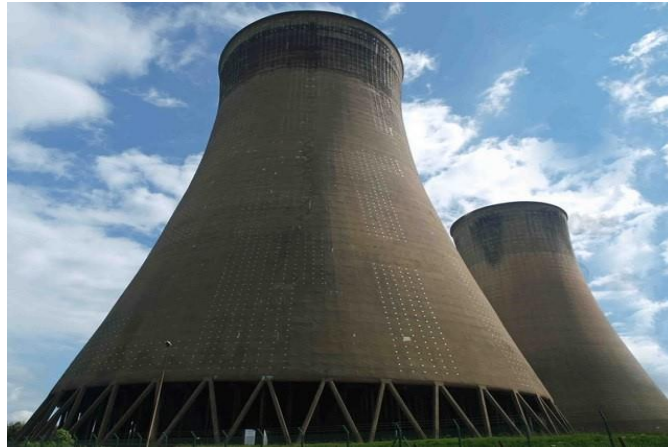
Figure 4.9 : Cheminées de refroidissement de la centrale à charbon.
