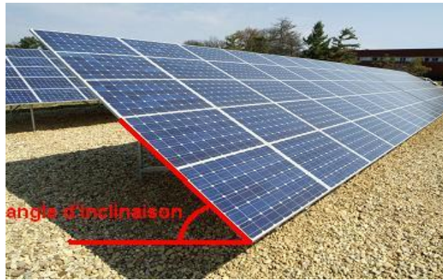
Figure(II-6): Orientation et inclinaison du panneau solaire.
