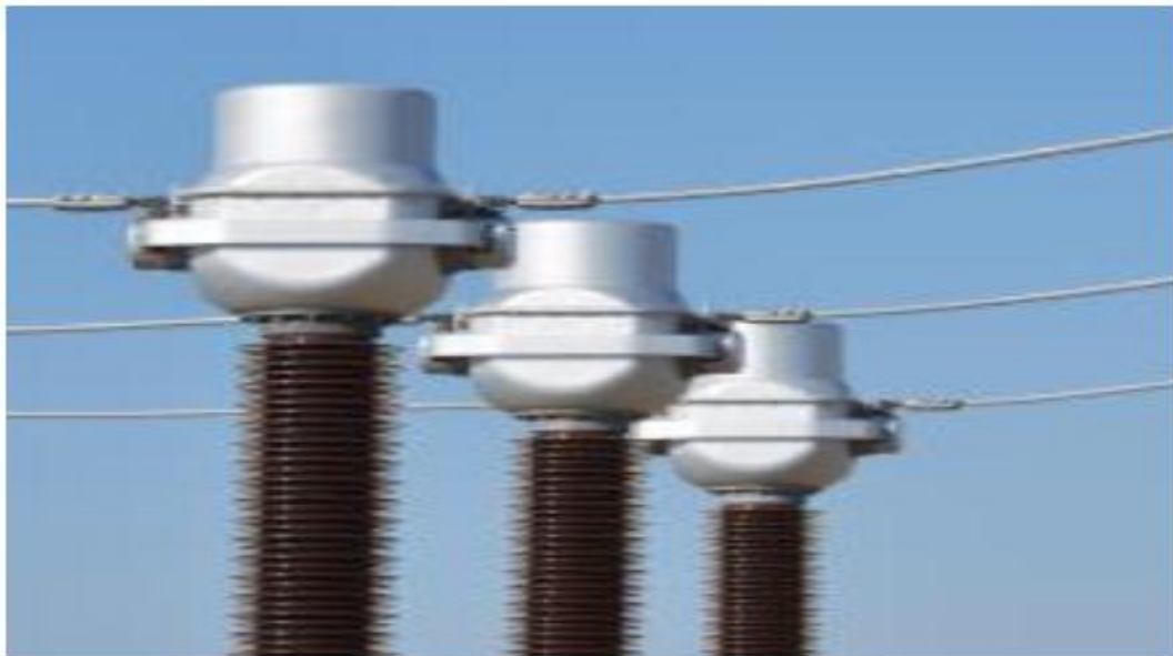
Figure III-3: Transformateur de courant. [19]
