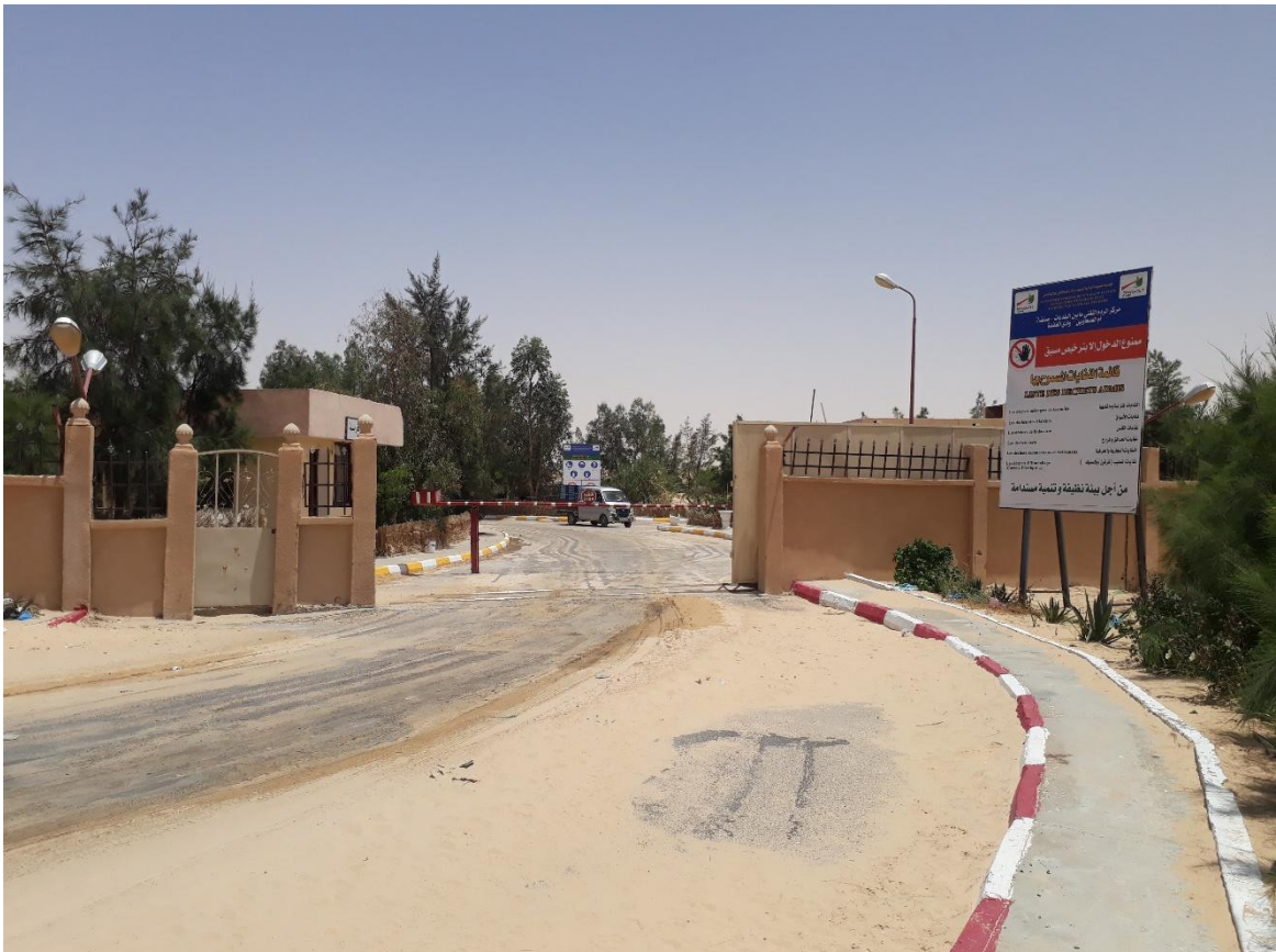
Figure 10 : Entrée du CET de El Oued
