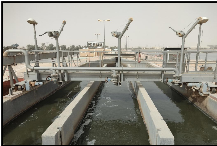
Figure 20 : Dessablage (Photo originale, 2022).
