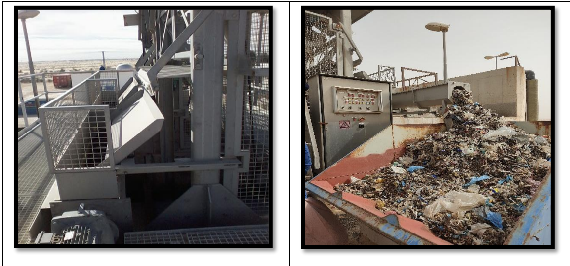
Figure 19 : Dégrillage (Photo originale, 2022).
