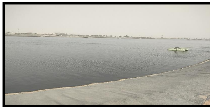
Figure 22 : Lagune aéré (Photo originale, 2022).
