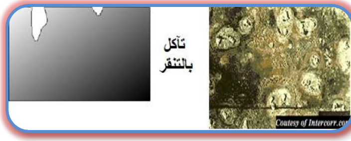
الشكل (5): صورة لتآكل بالتنفّر
