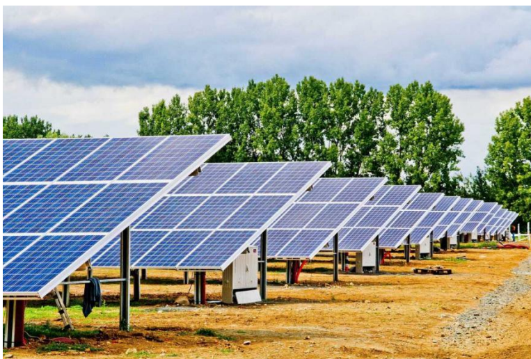
Figure.I.1. image correspondante à un panneau photovoltaïque.
