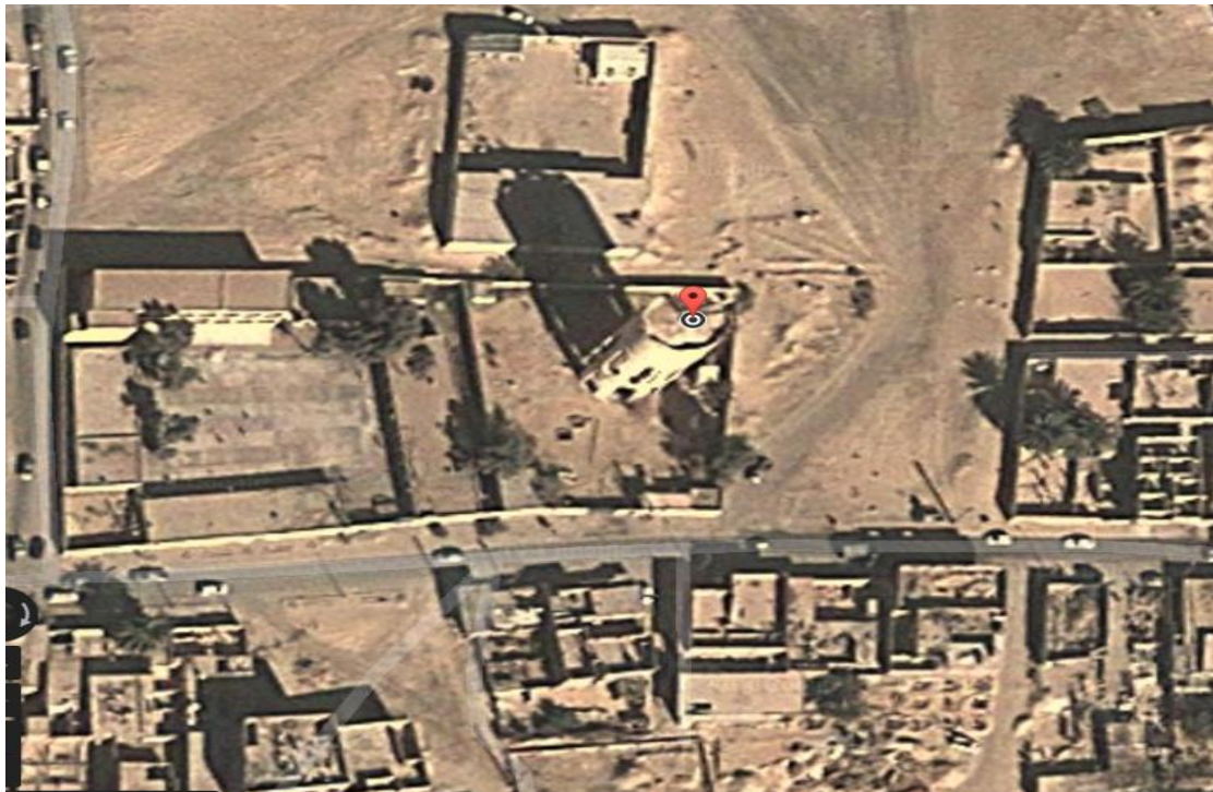
Château d'eau Sidi Mestour PAR GOOGLE EARTH
