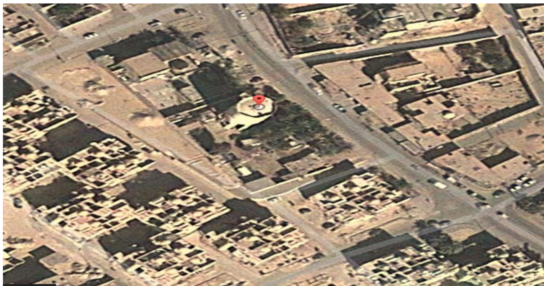
Château d'eau 400 logements PAR GOOGLE EARTH
