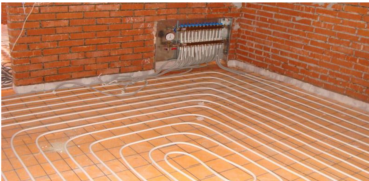
Figure I-2 : Photo montrant comment réchauffer le sol
