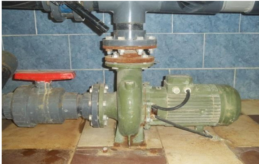
Figure 4.3 : Pompe centrifuge axiale
