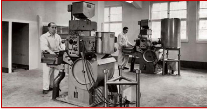
الصورة 1.I: اثنين من أول آلات كبسولة القشرة الناعمة لروبرت ب. شيرر، الذي أحدث ثورة في تصنيع كبسولات الجيلاتين الناعمة مع تطوره التصوير الفوتوغرافي. [1]
