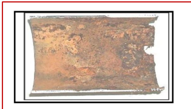
الشكل 10.I: تآكل غلفاني لبرونز [23]
