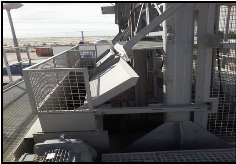
Figure 08 : Dégrilleur (ONA, 2009).
