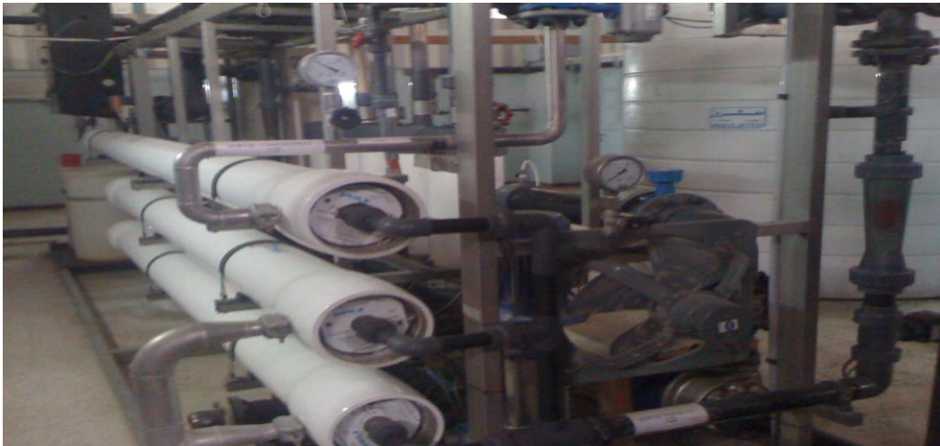
Figure 10: Les trois modules d'osmose inverse
