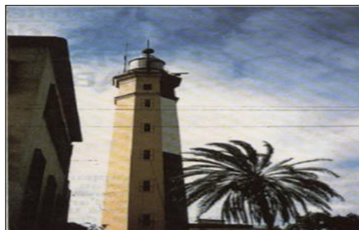
Figure I.1. Phare de Port Said réalisé en béton aggloméré Coignet (Egypte).
