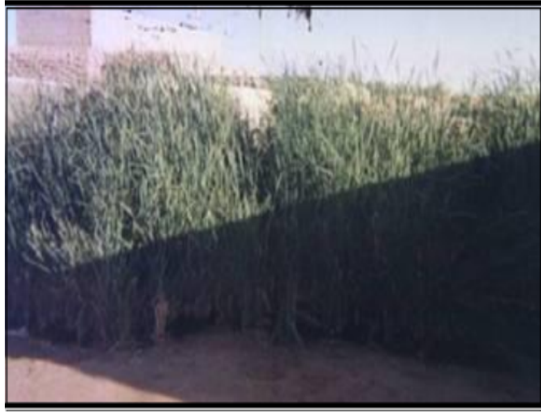
الصورة ( II. 2 ) توضح أثار صعود المياه على حي سيدي مستور بالوادي [16]
