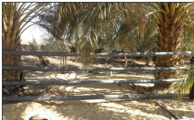
Fig16: L'installation des tuyaux
