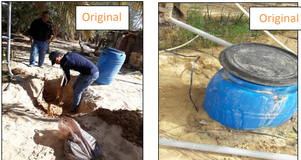
Fig17: Le placement du réservoir
