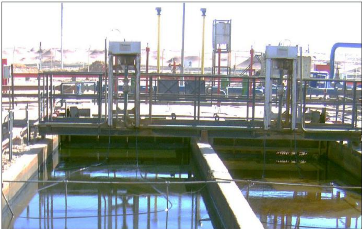
Figure III. 8: Skimmer à tube oléophile du bassin API de l'unité de déshuilage.
