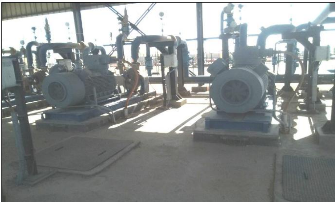
Figure III. 15: Les unités de filtration.
