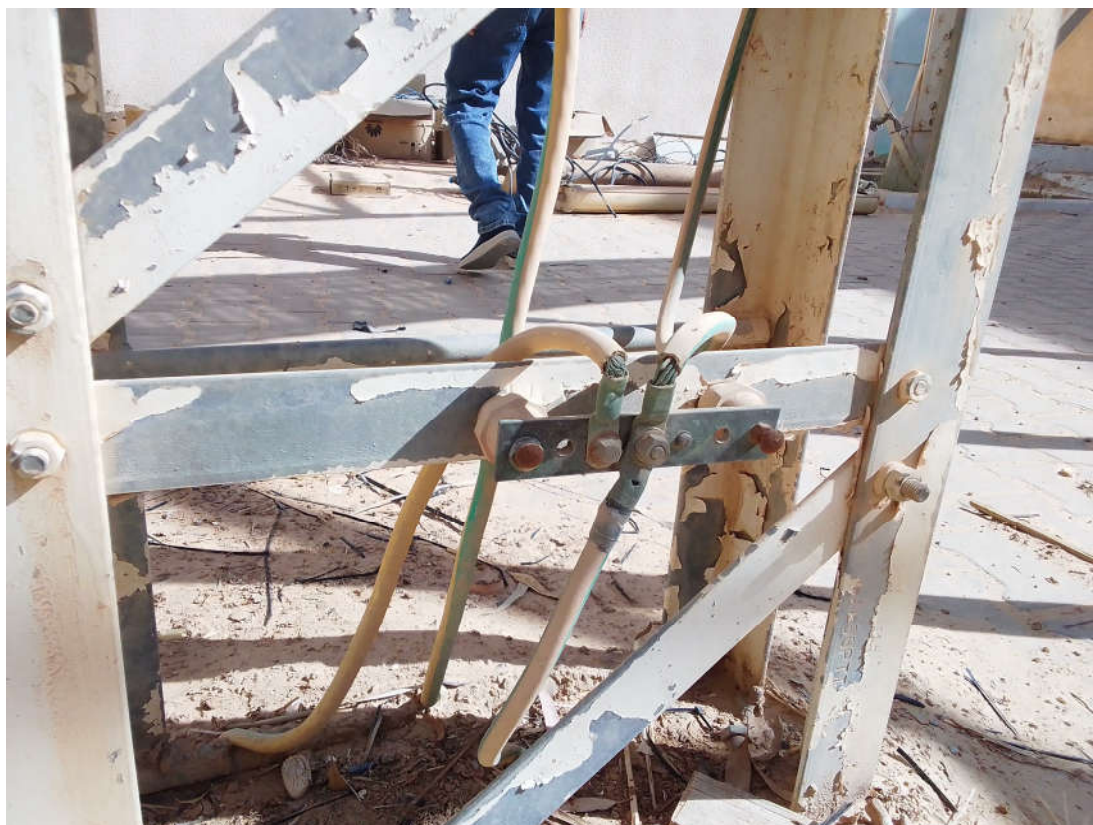
Image 7 : Mise à la terre ( autre exemple )
