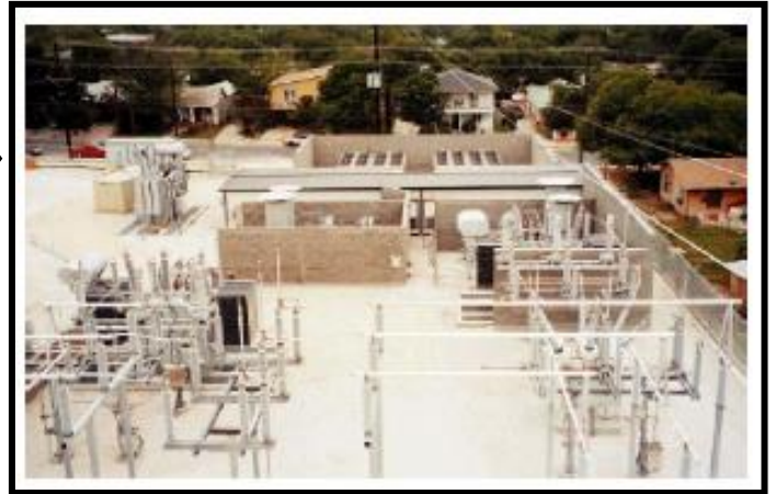
Figure (2-5): STATCOM installée dans les réseaux électriques
