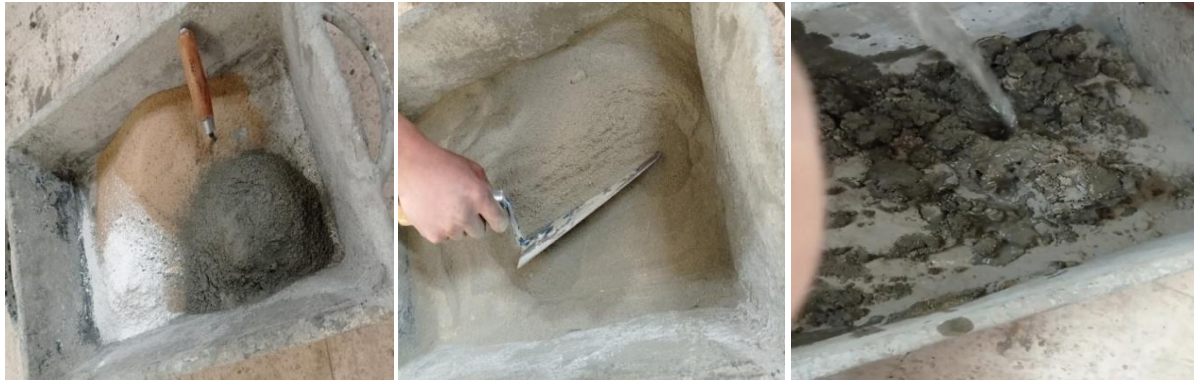
figure II 11 : Les étapes malaxage du mortier
