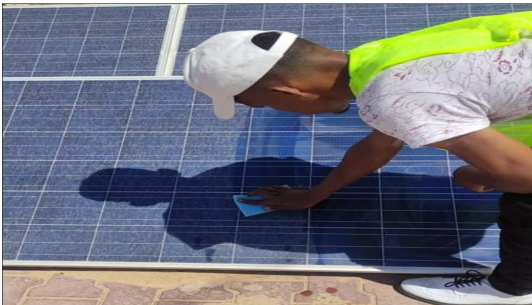
Figure III.3 : Nettoyer le panneau solaire de la poussière
