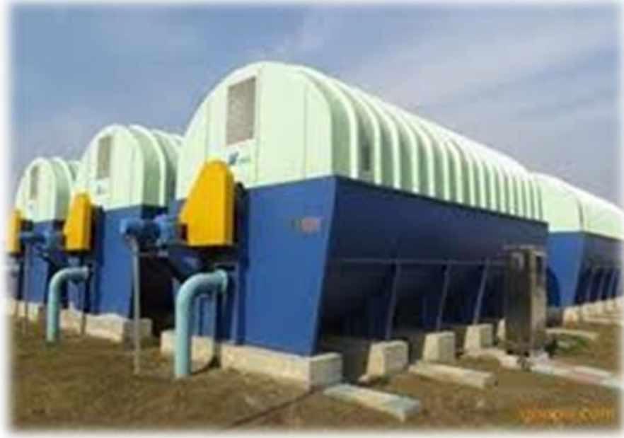
الشكل I.2. هيكل ثلاثي الأبعاد لموصل بيولوجي دوار [13].
