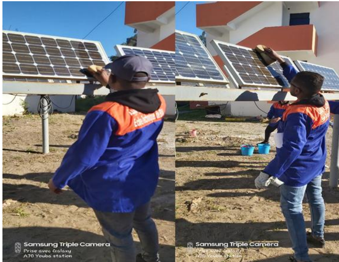
Figure II-10 : système PV (6kw)
