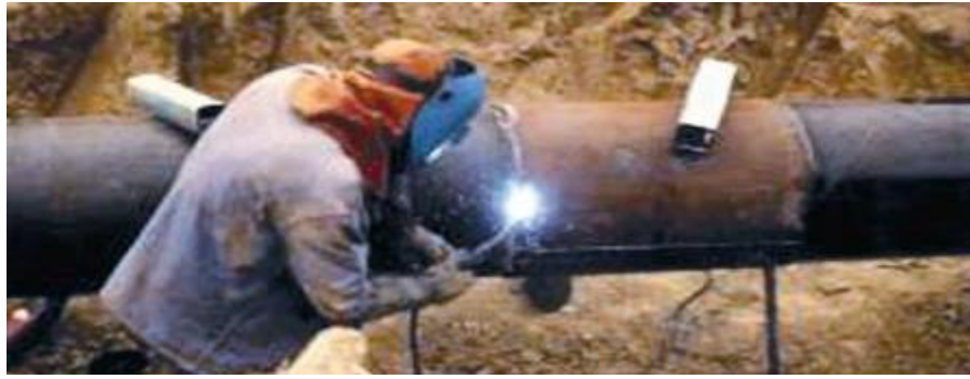
Figure III.21: Opération de soudages de demi coquilles (STT) [31].
