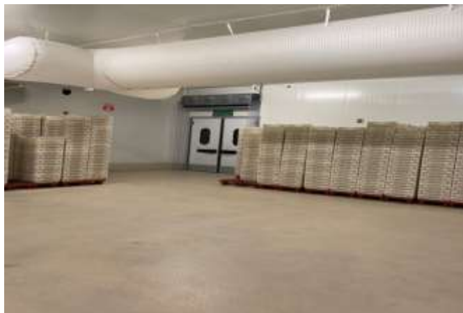
Figure n°25: Chambre de Repos (photo originale , 2024)
