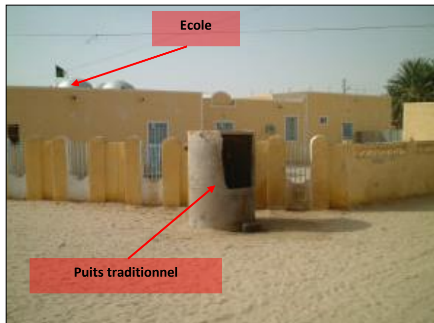
Figure 30 : Puits traditionnel pour Le réseau de surveillance de la nappe phréatique (Bonnard & Gardel, 2002c).
