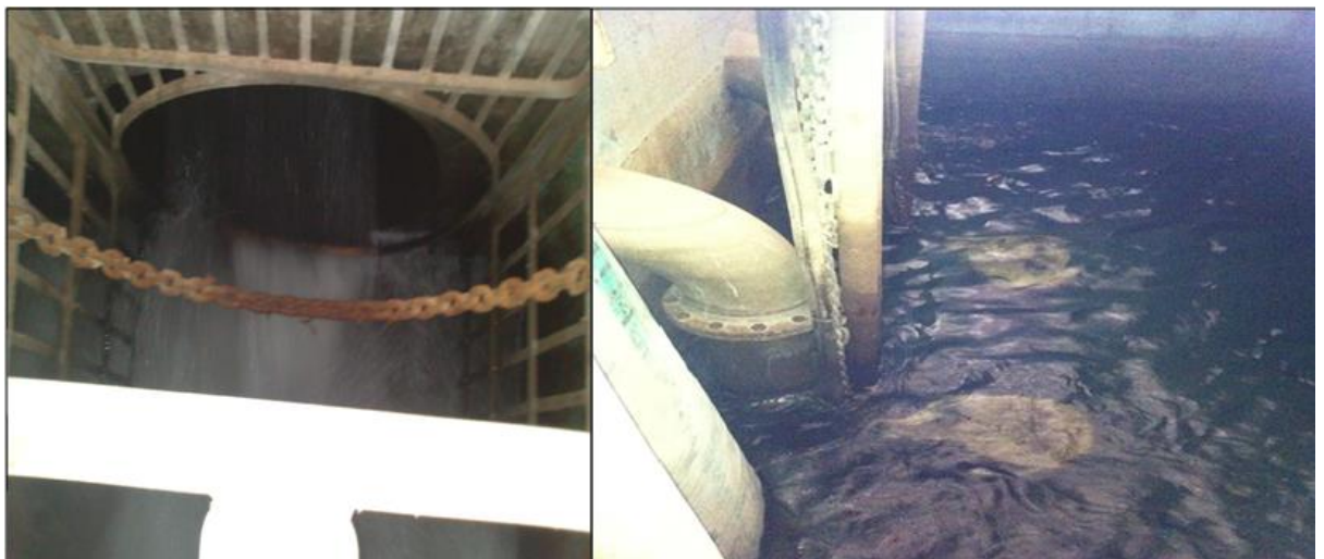
Figure 44: bêche d' eau des eaux de drainage ST10
