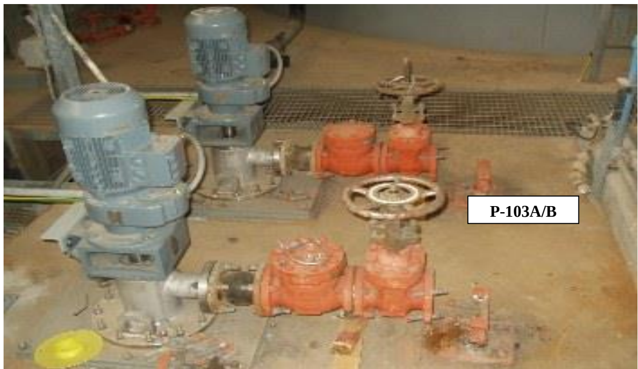
Figure III-18 : boues sont pompées
