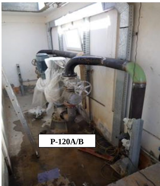
Figure III-5 : pompes volumétriques verticales
