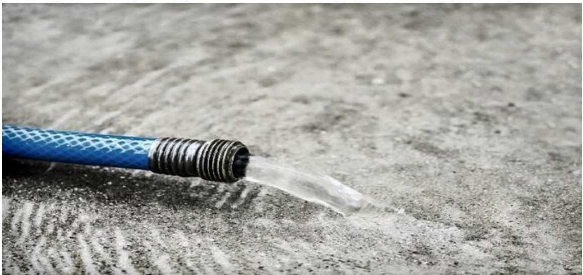
Figure I.6: Vaporiser le mortier avec de l'eau .
