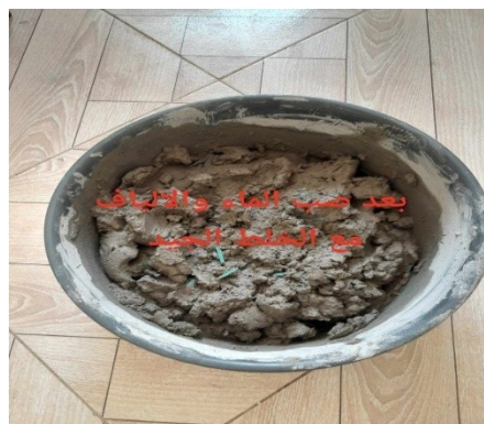
Figure. III 8. Ajouter de l'eau en mélangeant
