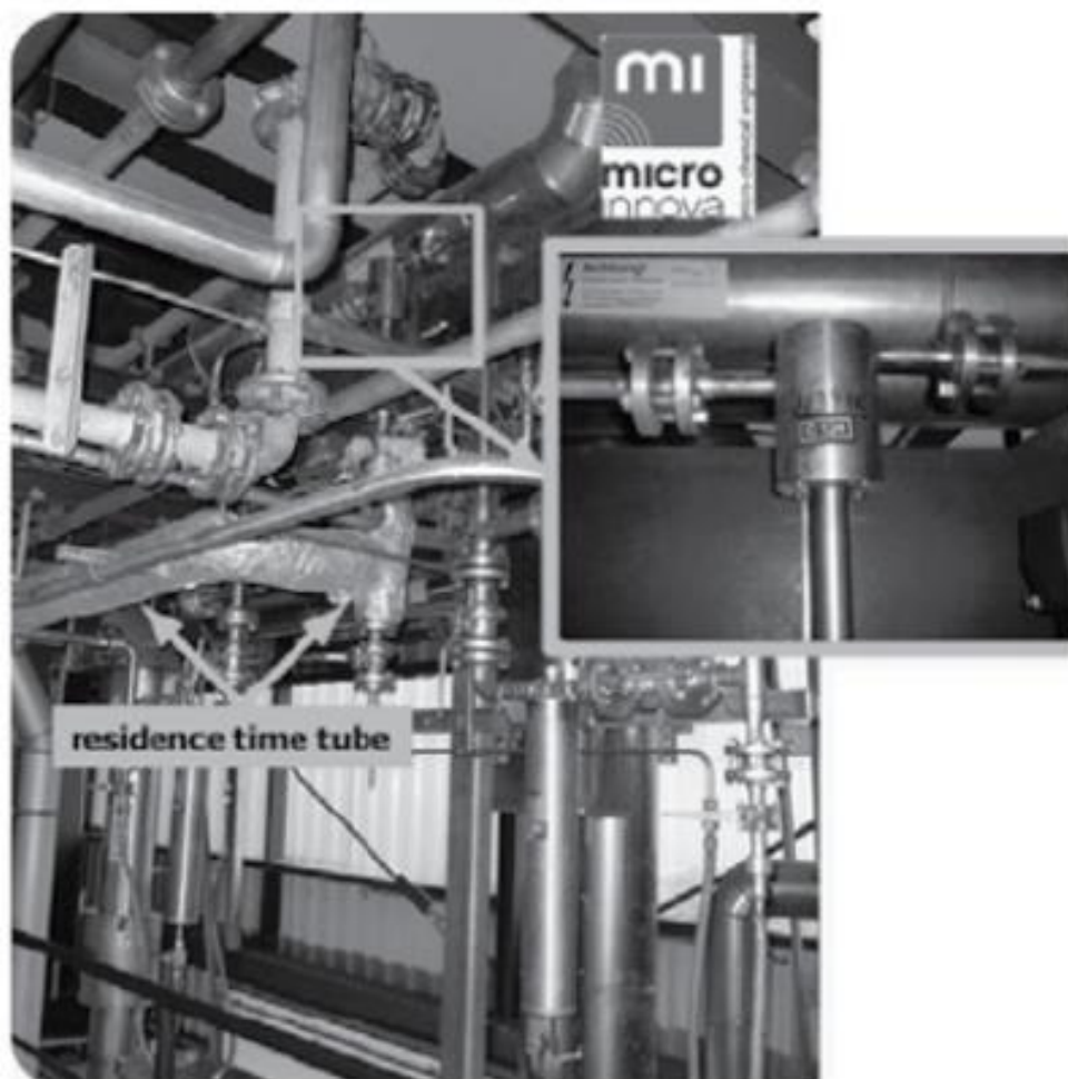
Figure 2 : Intégration d'un micro- réacteur dans une ligne de production industrielle pour des procédés de chimie fine (Kirschneck et Tekautz, 2007, avec permission). La capacité du procédé est de 3 t/h
