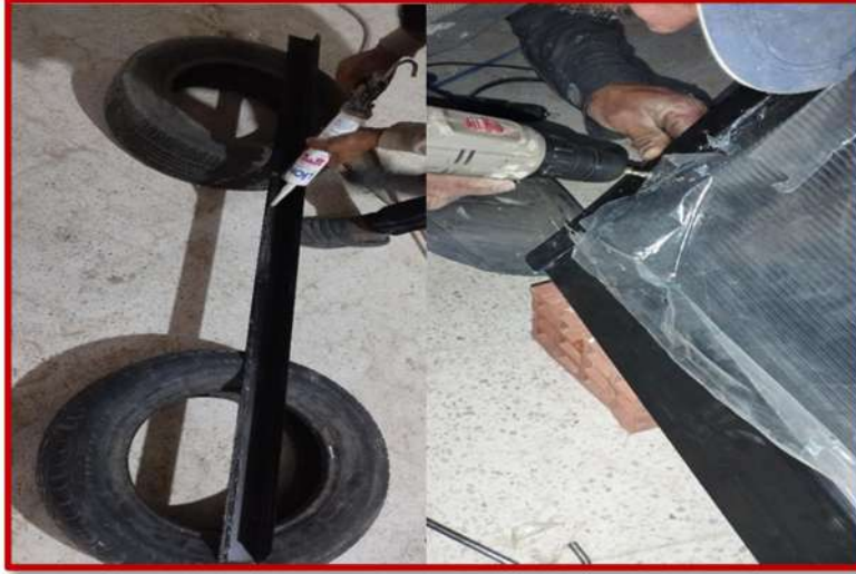
الشكل (III-7): الزاوية الحديدية وتركيبها.
