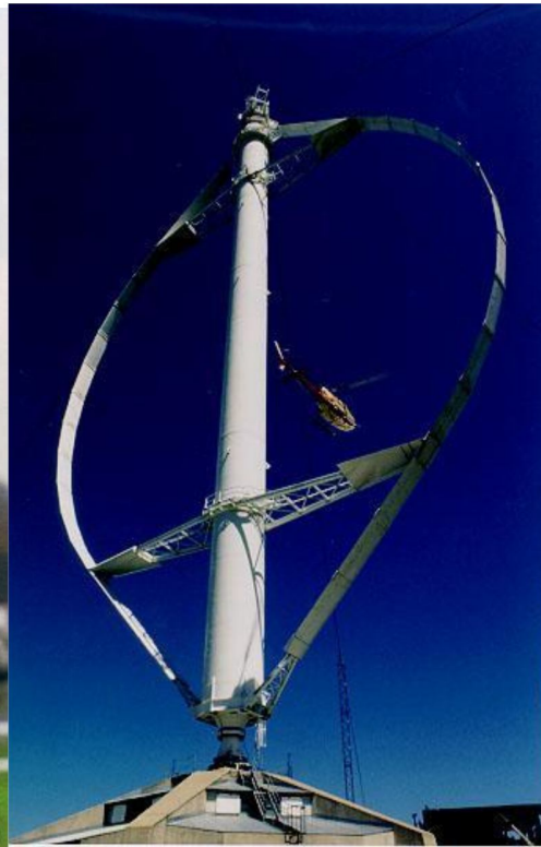
B-Éolienne de type Darrieus.
