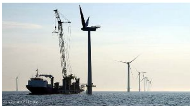
Figure I.3 installation d'éoliennes offshore en Mer de nord
