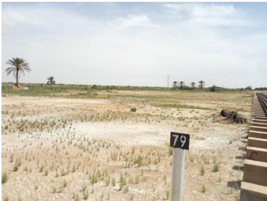
Ouvrage de protection du chemin de fer
