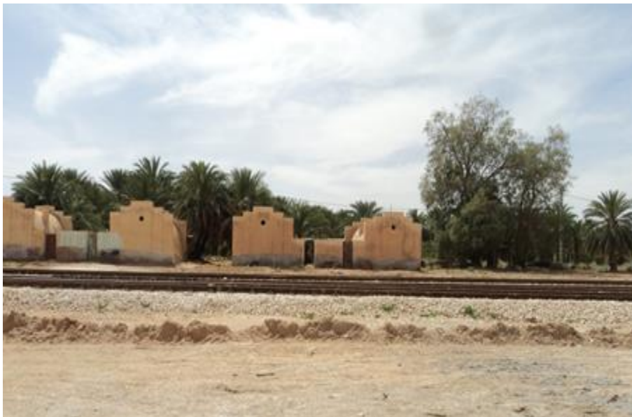
Zone urbaine touchée par les inondations
