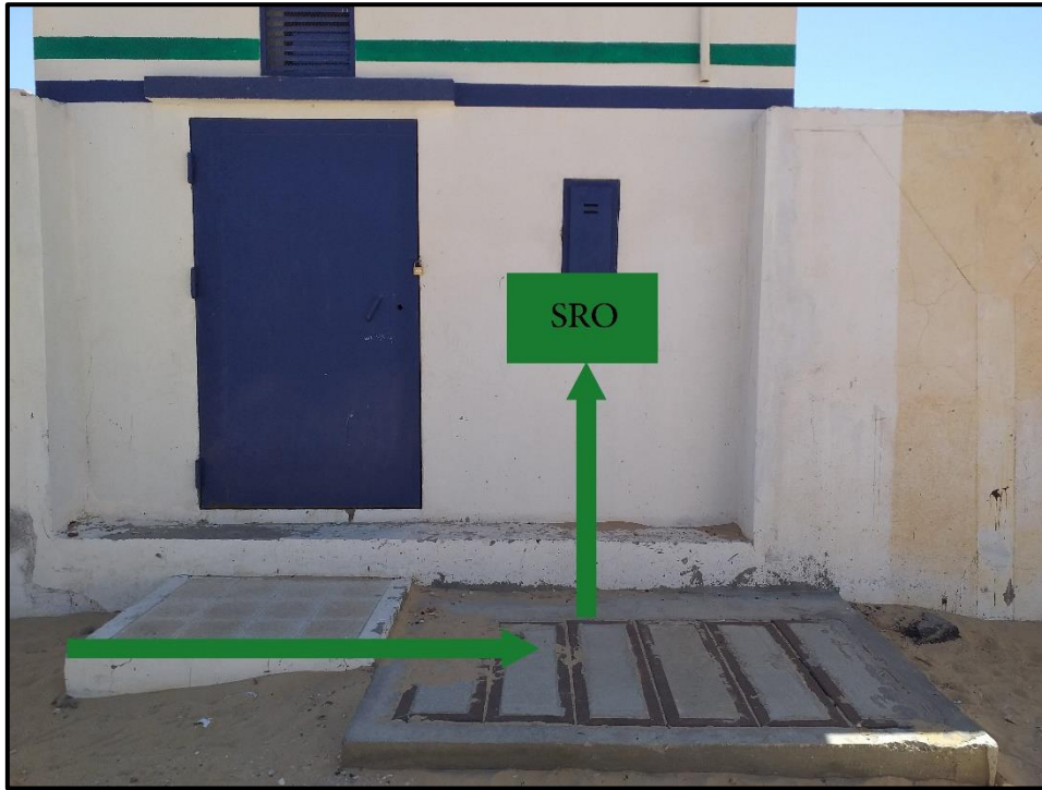
صورة 7: صورة حقيقية للمسار الذي سيسلكه الكابل.
