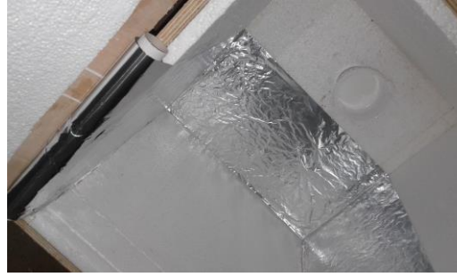
Figure (A.B.3): assemblage et collage des plaques (par clou et colle)
