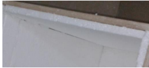
Figure (A.B.4) : Coller l'isolant sur le couvre et fixation des plaques
