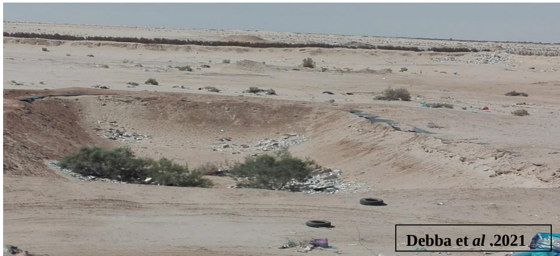
Figure N° 12: Bassin des lixiviats du CET de Nezla
