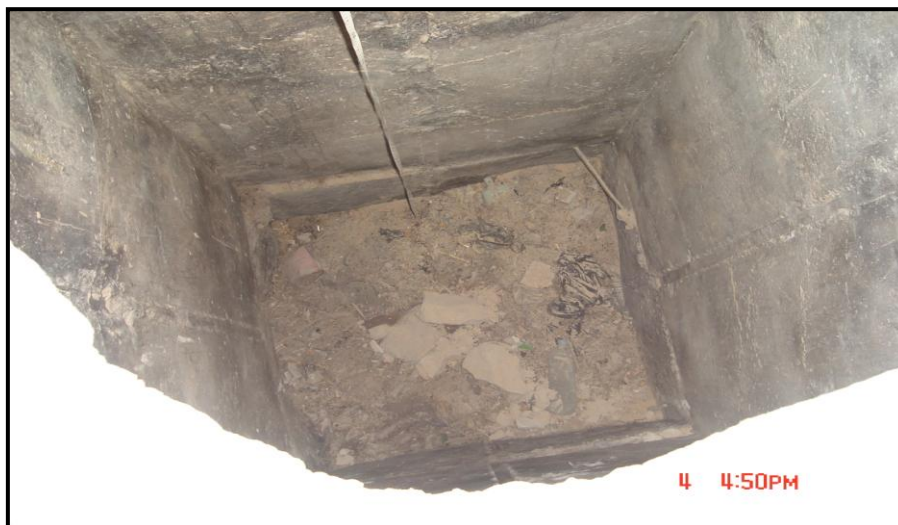
Figure II-3 type des regards n'est pas en service
