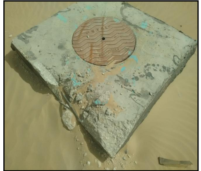
Figure II-4 type des regards a Ferrailage désastreux
