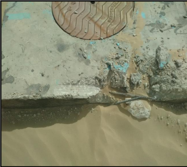
Figure II-4 type des regards a Ferrailage désastreux
