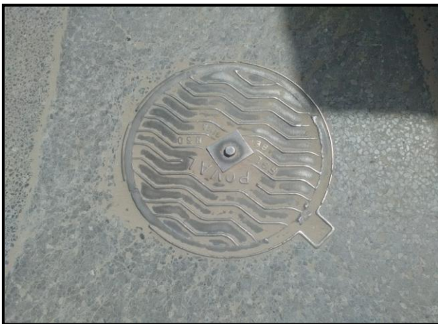
Figure II-5 type des regards avec des ouvertures fermeés
