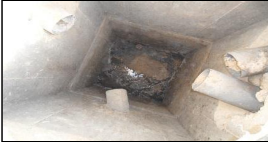
Figure II-6 type des regards chargés du sable
