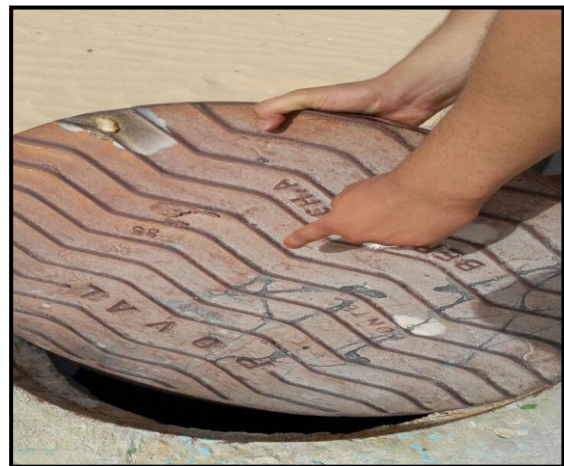
Figure II-5 type des regards avec des ouvertures fermeés
